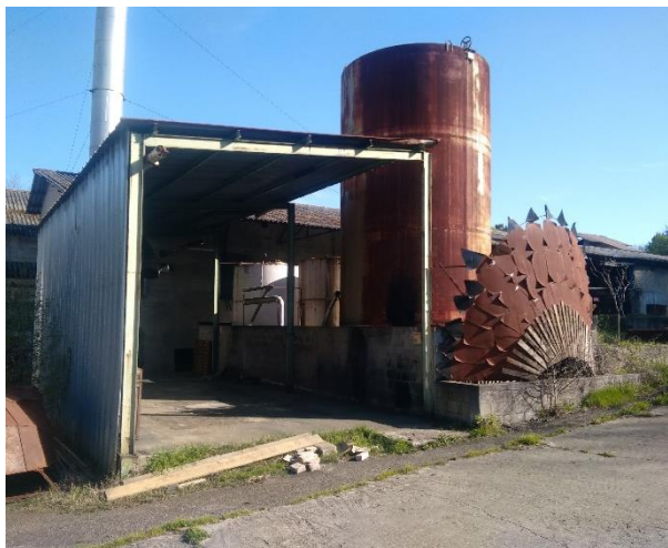
Photo 5 : Anciennes cuve aérienne de fioul lourd + cuves aériennes de graisses.
