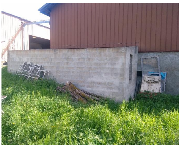
Photo 13 : Emplacement de la cuve aérienne de silicate de soude de l'ancienne cartonnerie.
