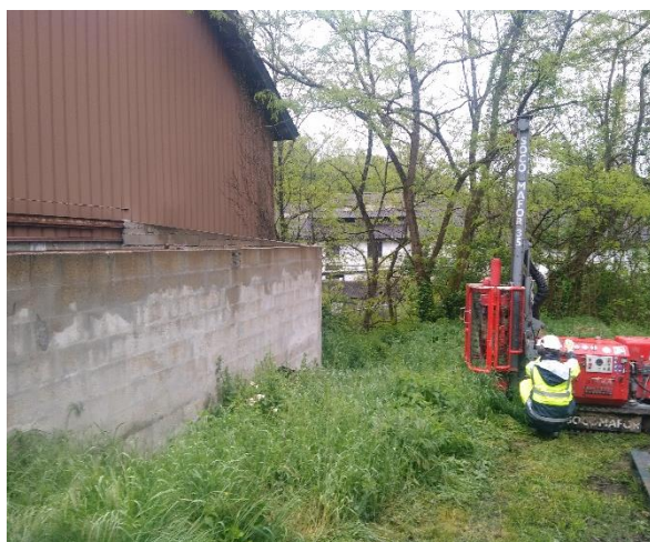
Photo 14 : Emplacement de la cuve aérienne de silicate de soude de l'ancienne cartonnerie. Prélèvement S10
